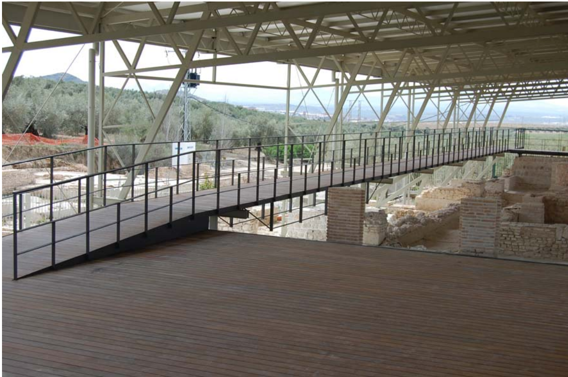
Imagen 45: Vista de la pasarela principal desde el puente de unión entre las pasarelas de madera y el camino de zahorra.
