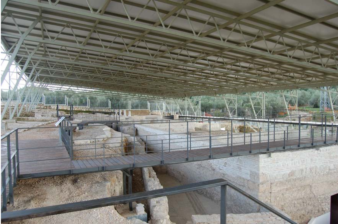
Imagen 47: Vista general de la carpa con las pasarelas y los caminos de zahorra.
