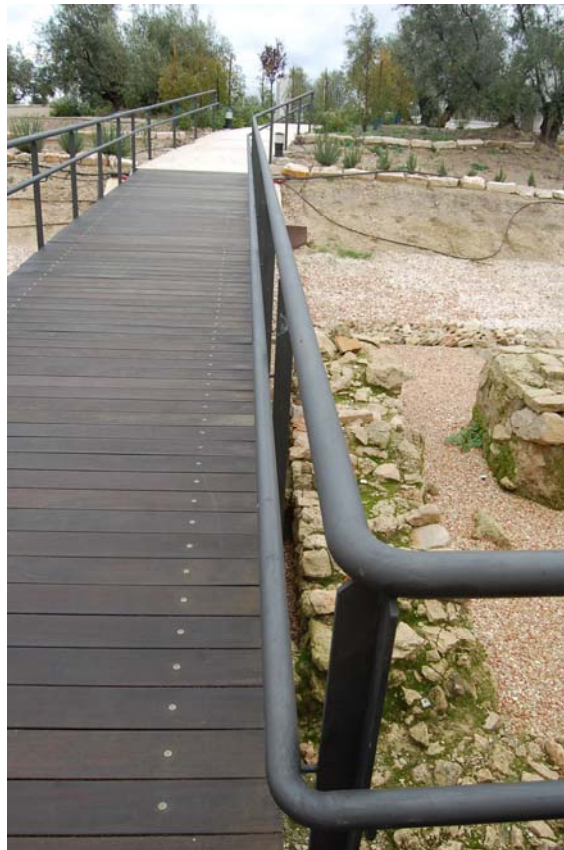
Imagen 8: Detalle del pasamano de la rampa de acceso a la entrada principal al centro de visitantes del yacimiento.
