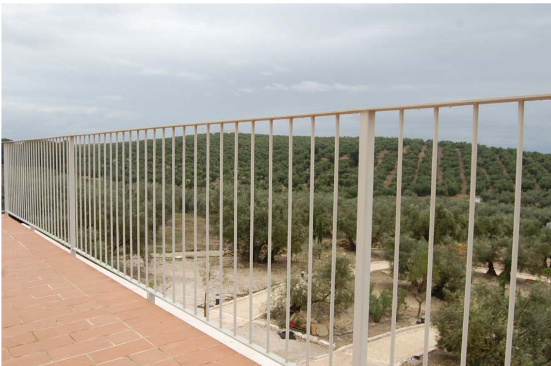
Imagen 16: Detalle de la baranda o pasamano que se encuentra en el mirador del centro de visitantes.
