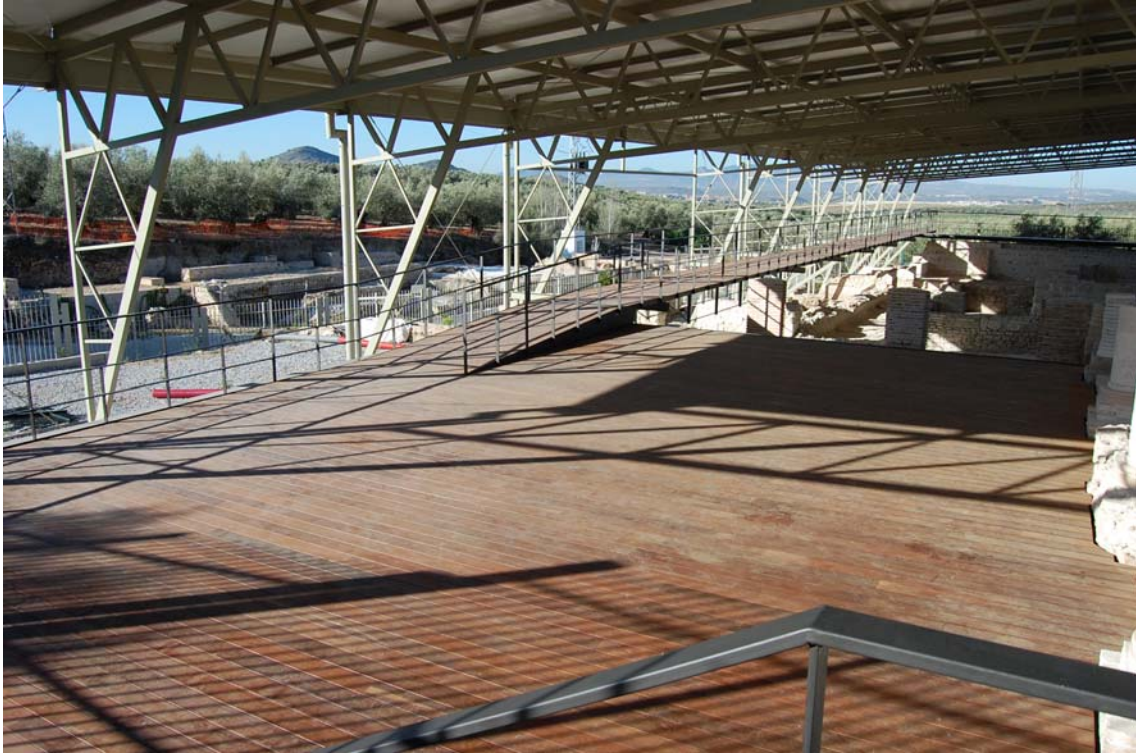
Imagen 41: Vista de la plataforma de madera de conexión entre las pasarelas de madera y los caminos de zahorra.
