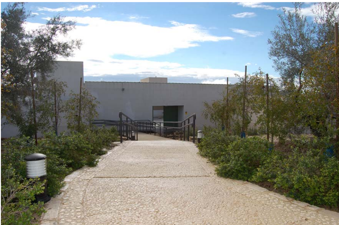
Imagen 6: Vista de la entrada al centro de visitantes desde la zona de tránsito ajardinada.
