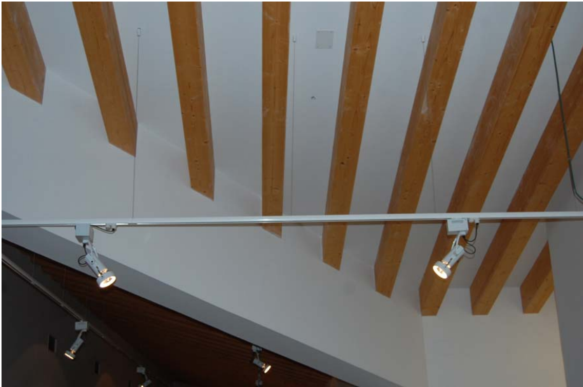
Imagen 27: Vista de la cubierta de madera que tiene la zona expositiva, y la iluminación por railes electrificados.
