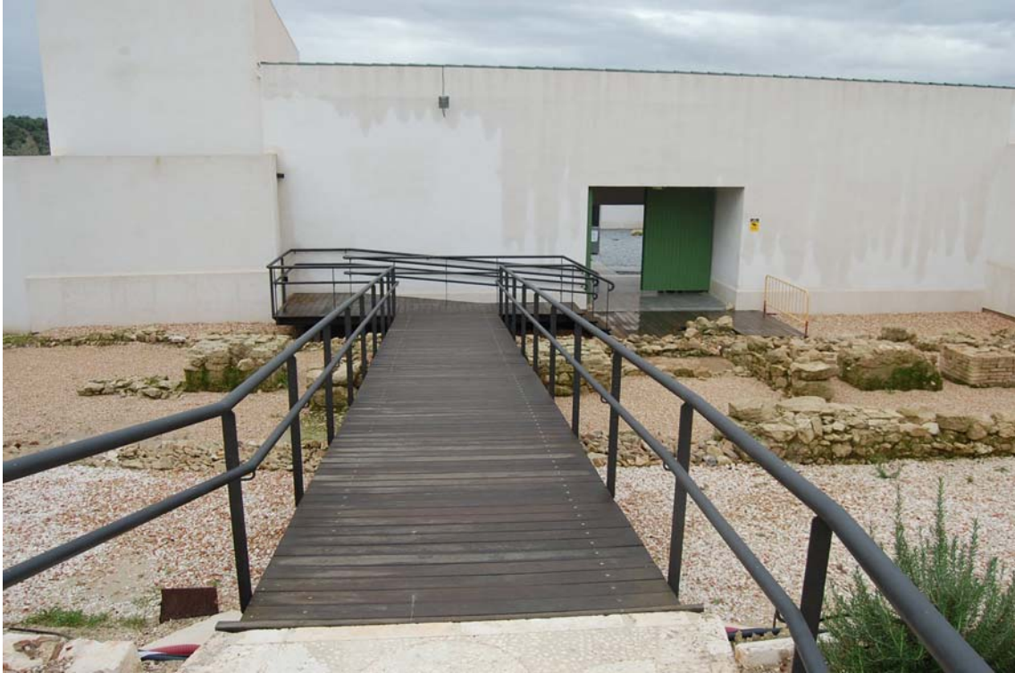
Imagen 7: Vista de la entrada principal al centro de visitantes. Se observa parte de los restos romanos que se localizaron en la zona y la rampa de entrada al centro.
