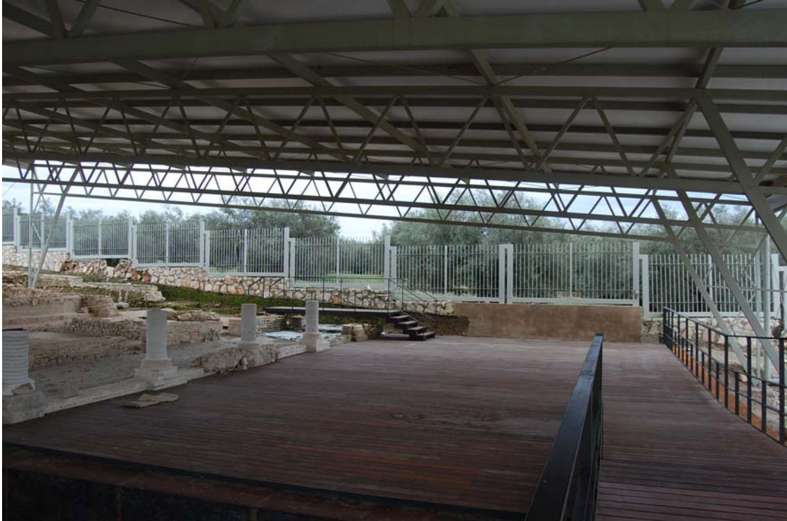
Imagen 43: Vista de la plataforma de visita a los restos desde la pasarela principal de la carpa.
