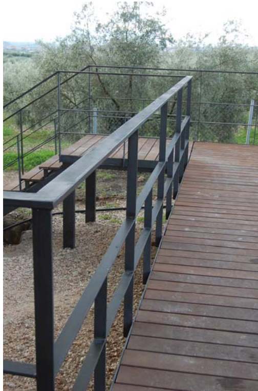
Imagen 49: Detalle del pasamano de las pasarelas de visita en el interior de la carpa.
